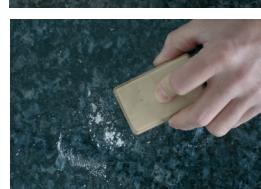
Rimuovere attentamente il materiale in eccesso con AKELUX Pialla. Per la pietra calcarea si raccomanda l'utilizzo di ossi di seppia. Quando si utilizza un timbro di struttura superficiale, questo passaggio viene omesso.
