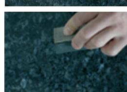
Posizionare AKELUX Panno abrasivo in silicone sul blocco di lucidatura e microlevigare a umido l'area danneggiata nella sequenza 2400-3200-4000. Quando si utilizza un timbro di struttura superficiale, questo passaggio viene omesso.
