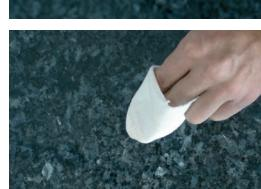
Applicare AKELUX Pasta lucidante sul punto da riparare. Lucidare manualmente con AKELUX Panno per lucidare e il lato in fieltro di AKELUX Blocco di levigatura e lucidatura oppure lucidare meccanicamente (ad esempio Dremel con disco lucidatore).
